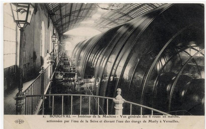
2. BOUGIVAL — Intérieur de la Machine - Vue générale des 6 roues en marche, actionnées par l'eau de la Seine et élevant l'eau des étangs de Marly à Versailles.
