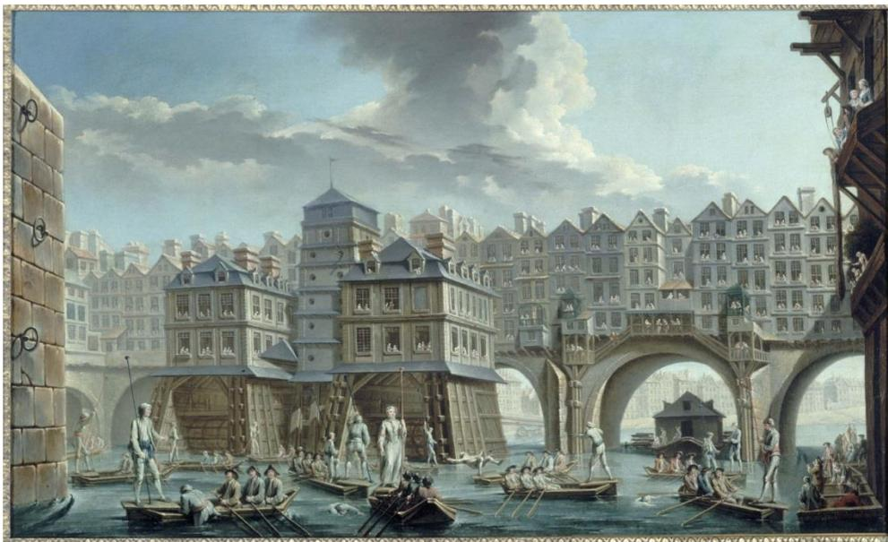
*Sur ce tableau du milieu du XVIIIe siècle, le pont Notre-Dame est encore surmonté de maisons en bois (détruites définitivement en 1786) et équipé d'une pompe qui a remplacé, au XVIIe siècle, les deux moulins à blé. Entre les arches du pont, on distingue le Port au blé. © N. et J.-B. Raguenet, La joute des mariniers entre le pont Notre-Dame et le pont au Change, 1756 - Musée Carnavalet / Roger-Viollet.*
