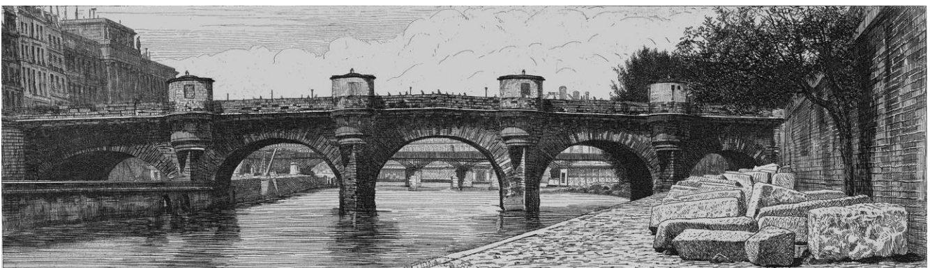
Le pont neuf en 1852 avec ses boutiques au-dessus de chaque pile
