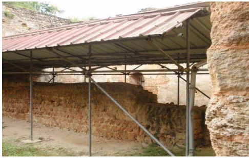
Mur de refend en calcaire coquillé
