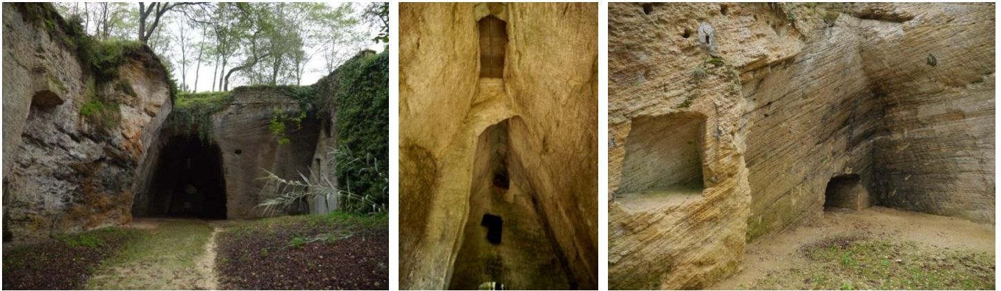
Galeries qui s'ouvrent sur d'anciennes carrières à ciel ouvert, Bâtières vues du dessous et amorce d'une galerie d'extraction
