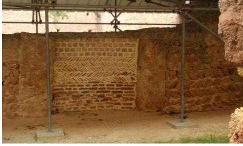
Cheminée dans la petite salle
