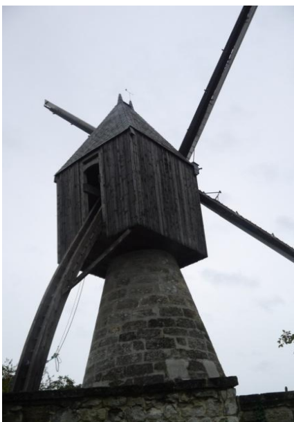
La hucherolle du moulin de Gouré posée sur le massereau et l'escalier qui y mène
