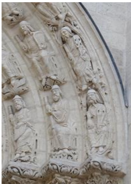
Détail d'un portail de l'abbaye
