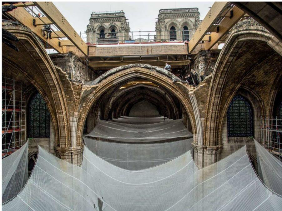
Des bâches protègent l'intérieur de la cathédrale des intempéries, afin que l'édifice puisse être sec avant d'entamer les travaux de restauration.
