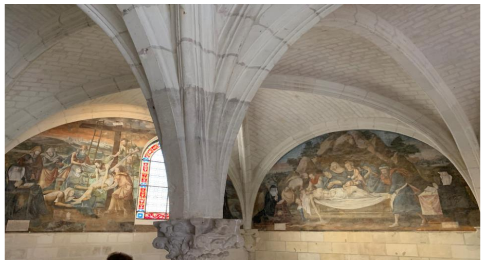
Une des fenêtres géminées de la salle capitulaire et plafond de la salle capitulaire
