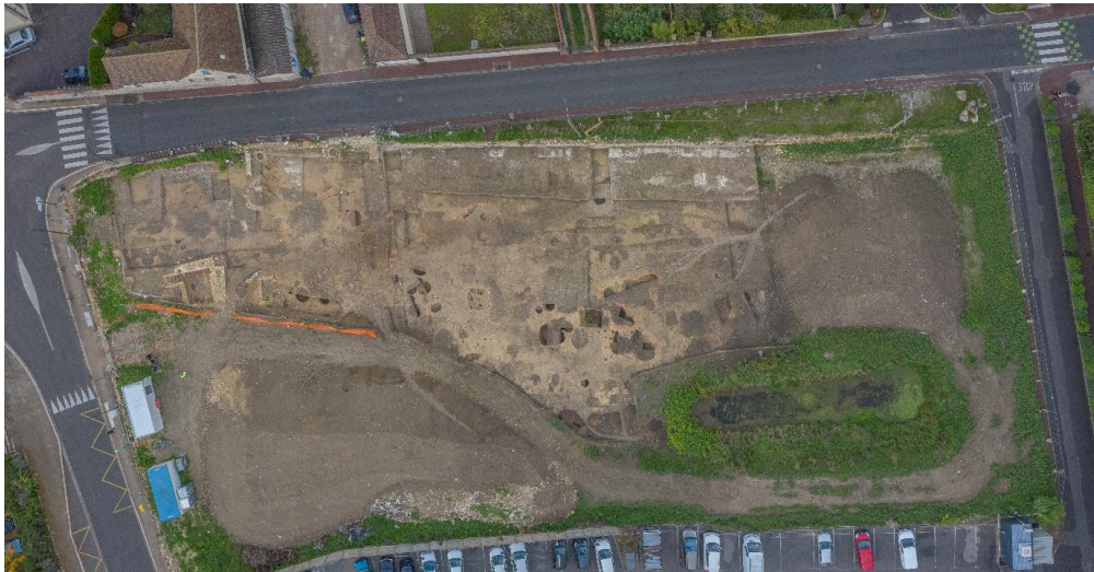
Vue drone du chantier (© MADE – CD27)
