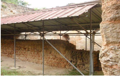
Mur de refend en calcaire coquillé
