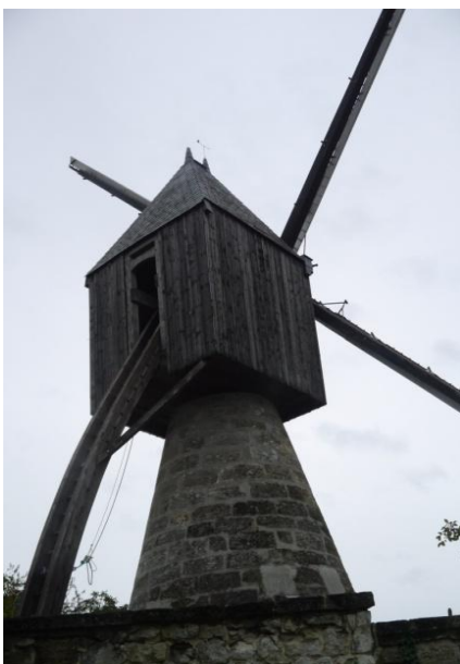
La hucherolle du moulin de Gouré posée sur le massereau et l'escalier qui y mène
