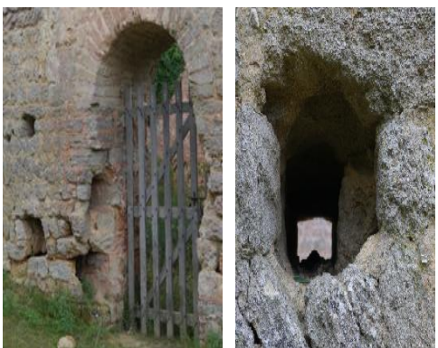
Trous pour les poutres de blocage ouverture de la porte et trous d'ancrage des poutres plancher
