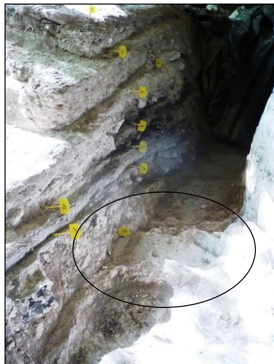
Fig 03 : vue du ressaut (cerclé)
