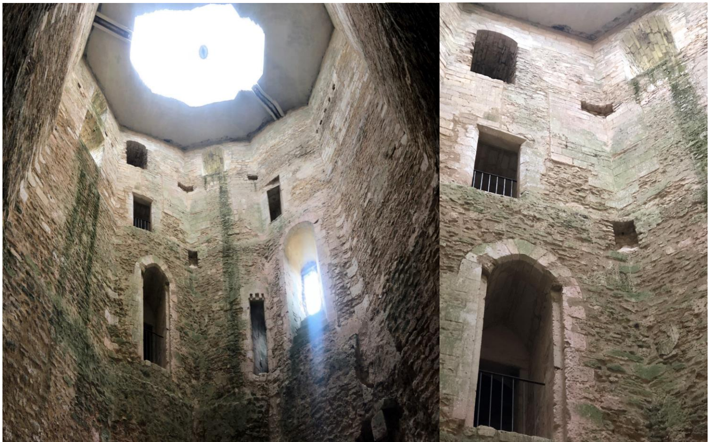
En haut vue extérieure de la porte de l'accès d'origine au donjon qui se faisait par une échelle à la porte des Champs; en bas vues intérieures du donjon où l'on distingue les différents niveaux ajoutés au fil des siècles.
