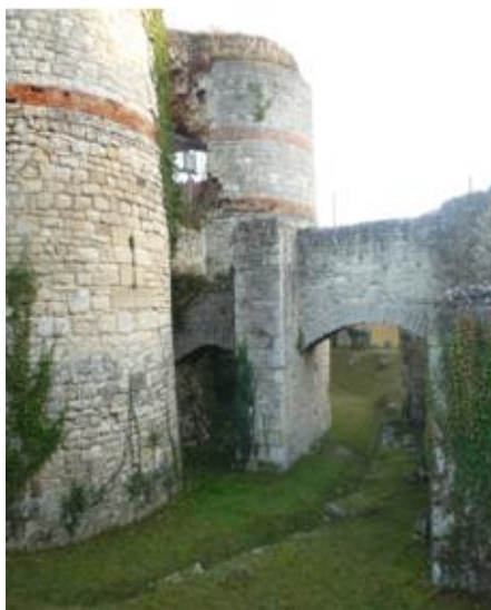
Vue, d'une partie des douves, des deux tours du châtelest ouest et du ravelin (ou barbacane)
