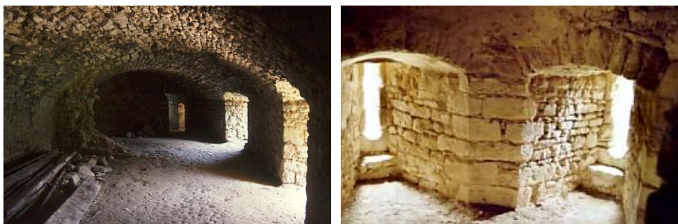
Vue intérieure des casemates et des meurtrières type arbalétrières-canonnières.
