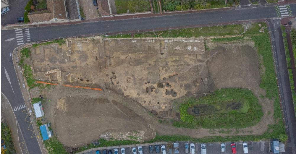
Vue drone du chantier (© MADE – CD27)
